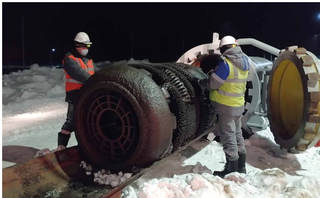
Дюртюлинцы на ВТД газопровода Уренгой–Новопсков
