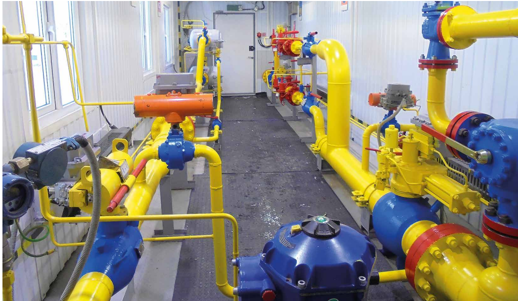
После комплексного капремонта повысились эксплуатационные показатели надежности и энергоэффективности станции
